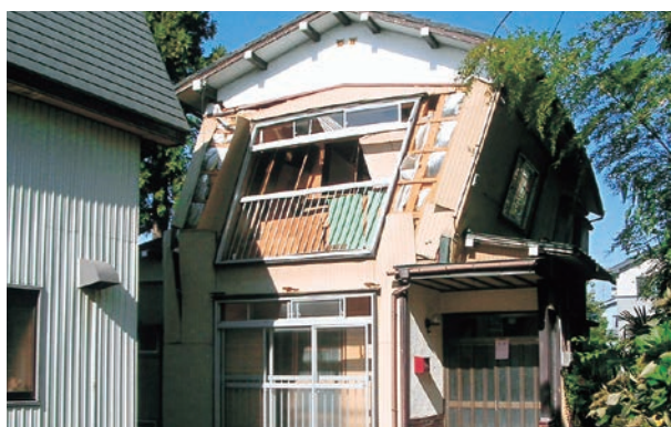
Ngôi nhà bị phá hủy do không chịu được động đất (Động đất Chuetsu-tỉnh Niigata năm 2004)
