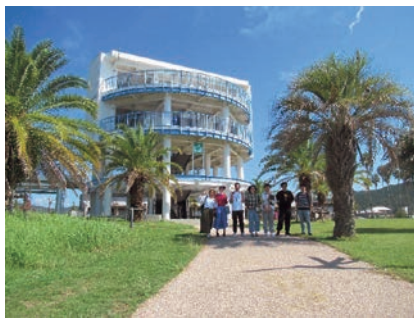
【B-2】 Tsunami evacuation tower
